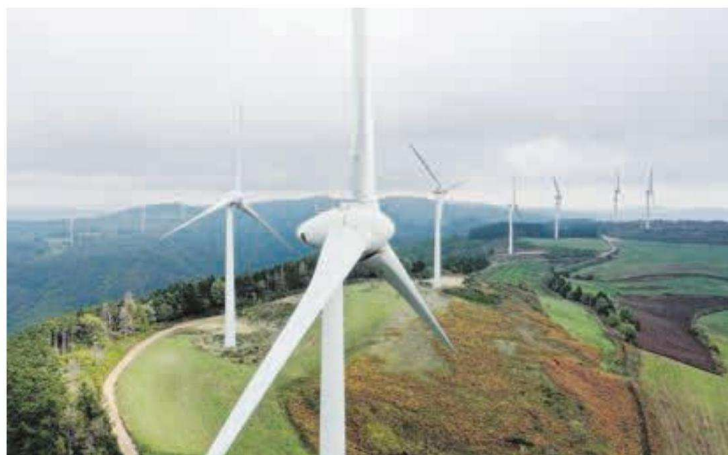
Malgré l'annulation, par deux fois, de leur permis de construire, les éoliennes de Bernagues-Lunas ont été implantées sur un site classifié zone naturelle d'intérêt écologique faunistique et floristique et sont en service depuis 2016.
